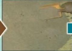
次にクリーン・スイープを流出したオイル全体に撒くことで、速く吸収吸着させ、回収効率を上げていきます。
